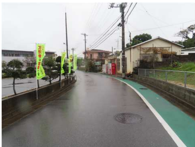
写真 3.2.5 路肩のグリーンベルト（嘉手納町）
