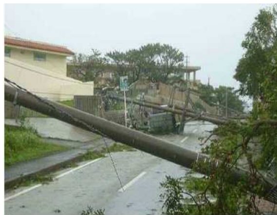
写真 3.2.2 平成 18 年台風 13 号 (石垣市)
