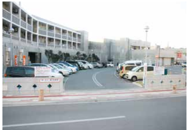
ロータリー第 2 駐車場
