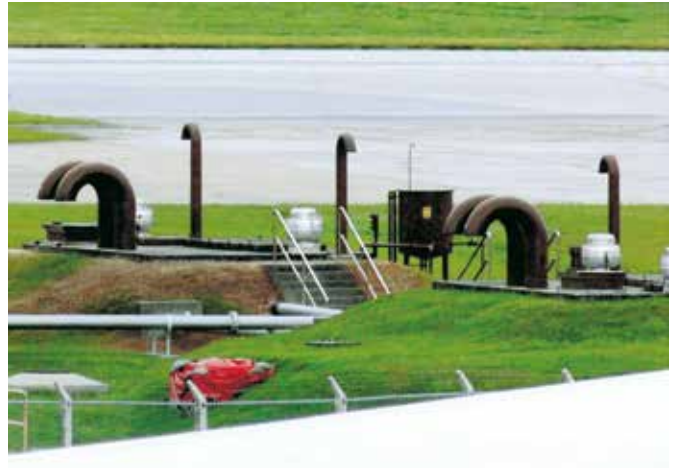
流出が起きた燃料タンク 沖縄タイムス 2007年(平成19年)6月7日
