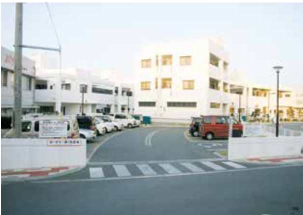
ロータリー第 1 駐車場
