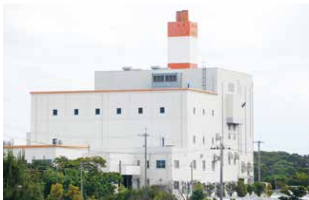
ごみ焼却処理施設
