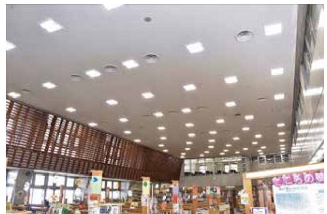
嘉手納町立図書館照明取替工事
